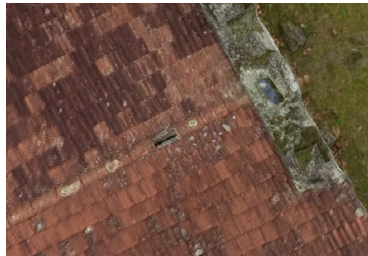
DETALLE FALLO CUMBRERA
